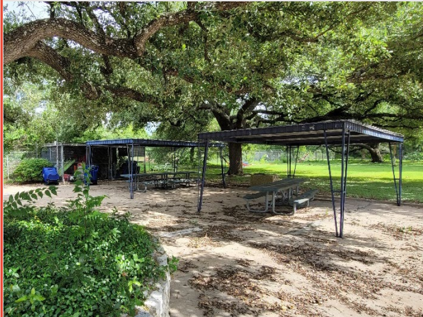
Metal Canopies at East Deck Estructuras metálicas
