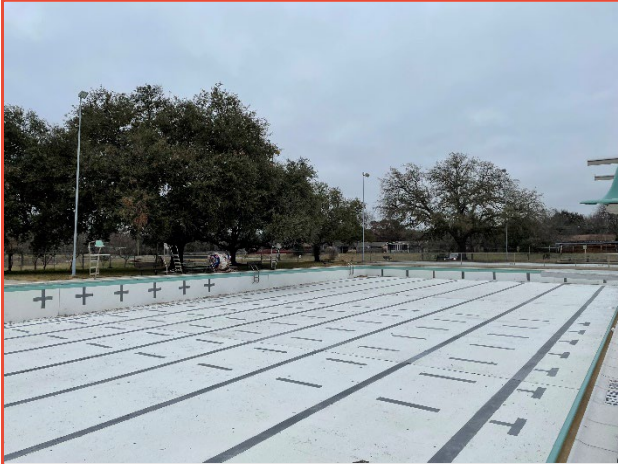
Concrete Shell Cascarón de concreto
